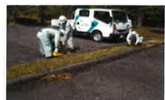
外構清掃作業
