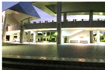
（吉備中央町コリドール広場）
