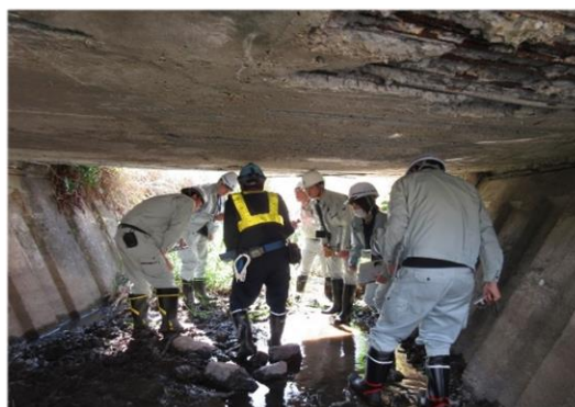
橋梁点検実習状況
