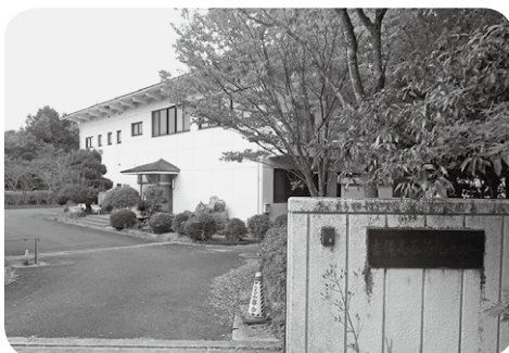
電気設備を改修・浄化センター
