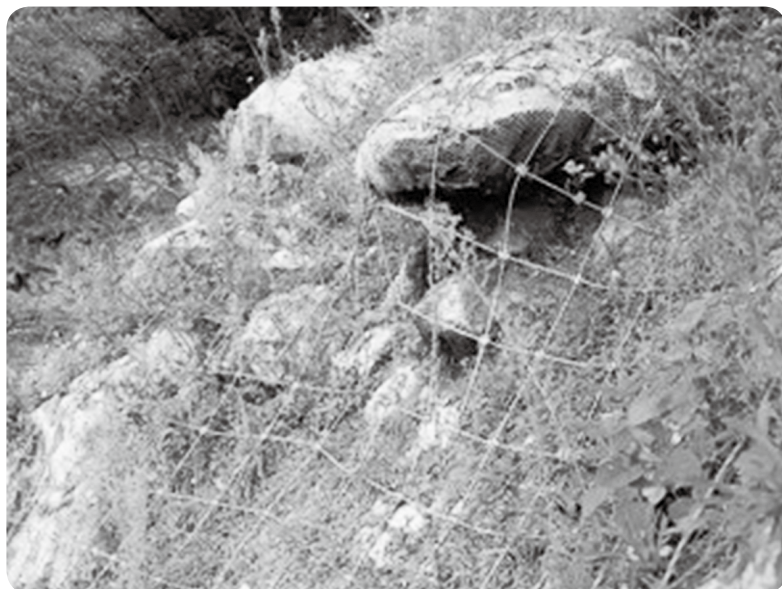
ワイヤーネットで危険防止を (参考写真)
