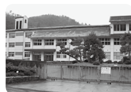
期待される新設中
