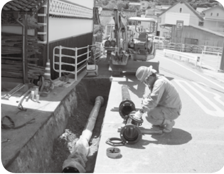
周辺に配慮した工事
