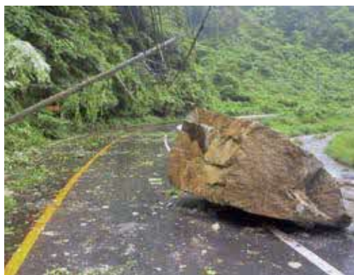
◀ 落石発生の状況(令和5年6月30日)
