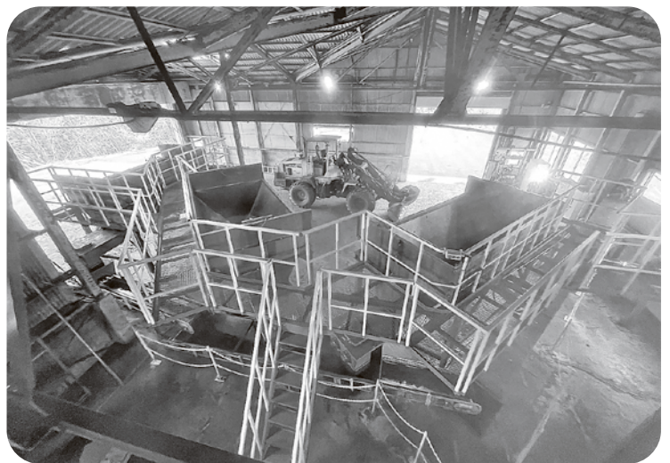
防護柵を設置
