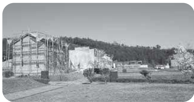
建設が進む吉備高原都市
