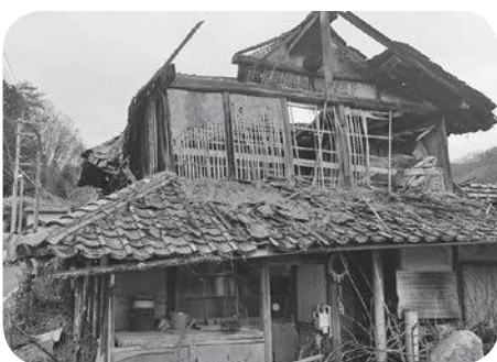
倒壊寸前の空家
