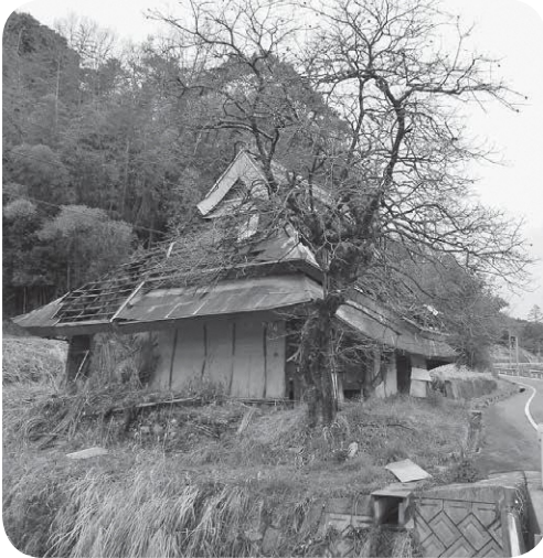
危なくなった空家
