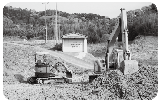
進む機庫整備
