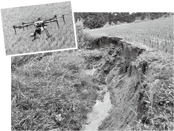
豪雨による法面の崩壊
