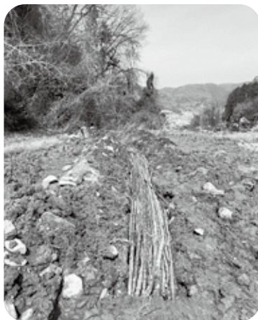
あんず山 暗渠排水工事
