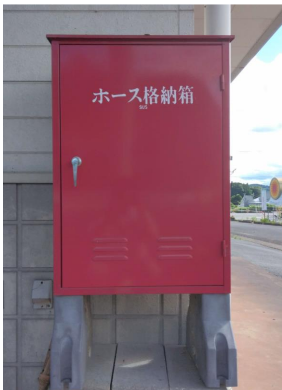
【消火栓ホース格納箱】
