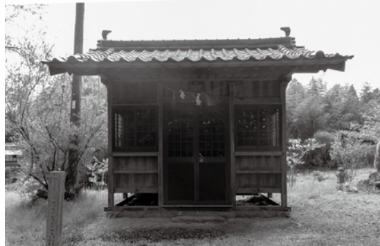
通常時は厨子内に鎮座しています。（非公開）
