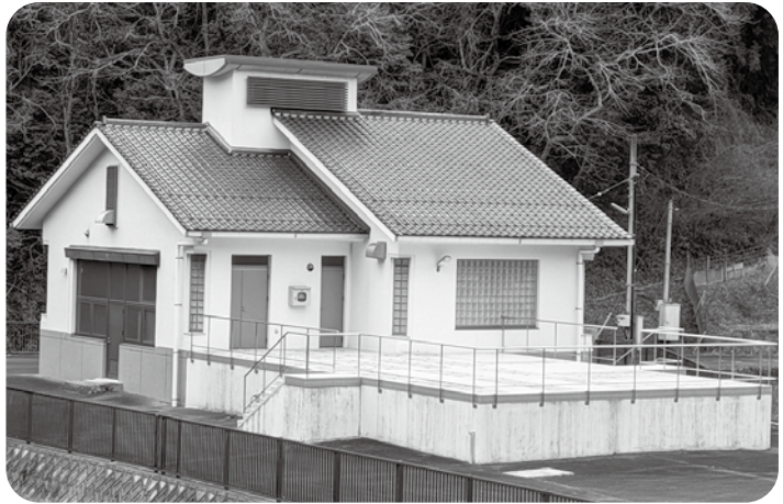
農業集落排水処理場
