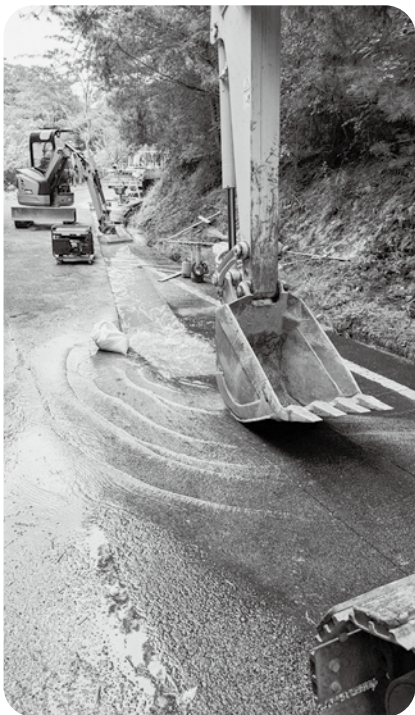
漏水による緊急工事
