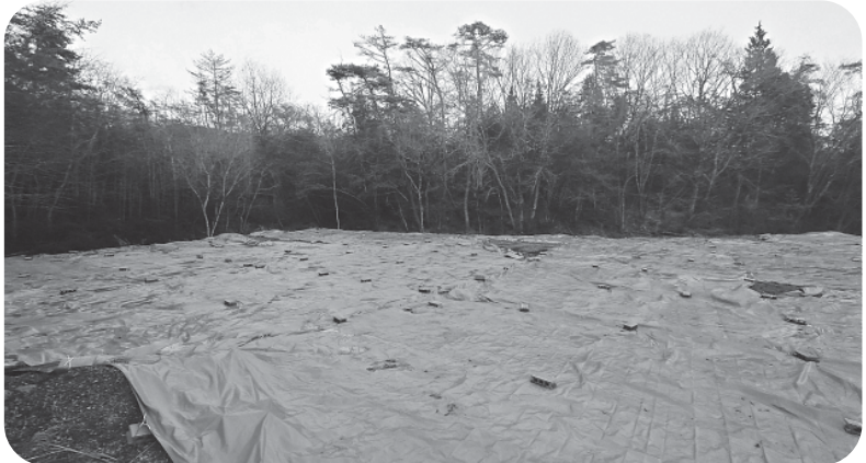
浸透防止のため設置されたシート
