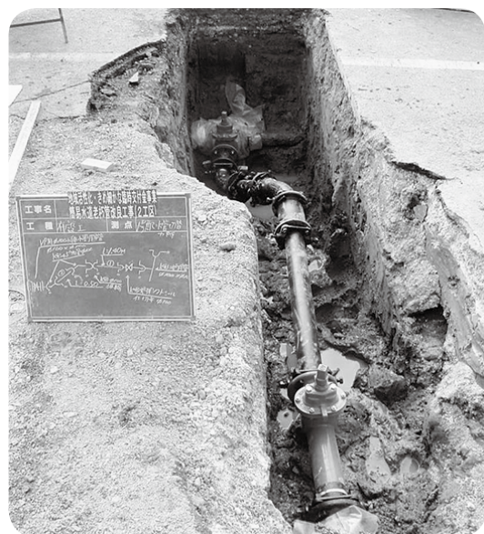
進む、老朽管の改良
