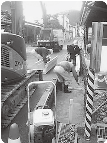
整備が進む町道
