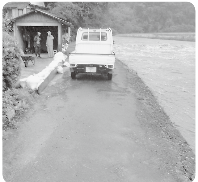
早急に護岸工事を
