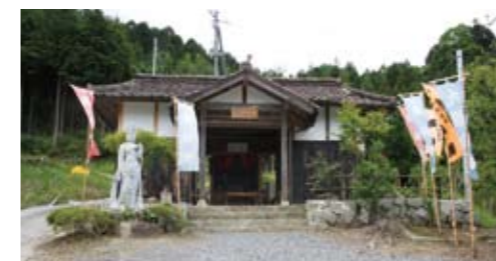
一部改修後の拝殿
