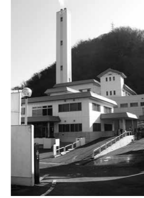
高梁地域事務組合 クリーンセンター (高梁市段町748)
